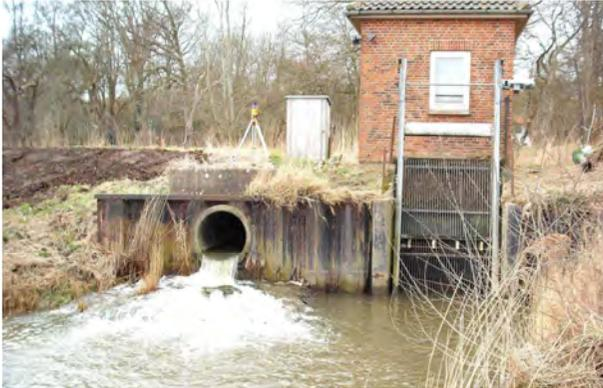
**Verbindungsbauwerk DN1000 mit Schieber**
